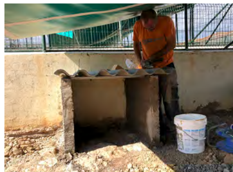
Micha baut Unterstände
